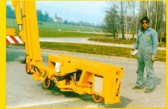
Elektro-hydraulisch wird die Bühne in Arbeitsstellung gebracht und ausgeklappt.
