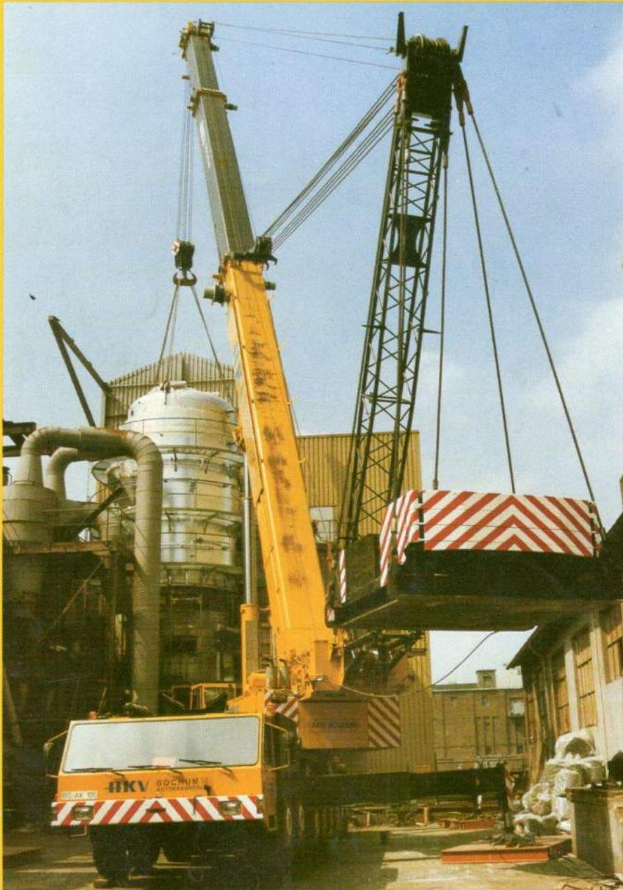
Die Montage eines 75 t schweren Reaktors in der Ölfabrik Thywissen/Neuss führte die Firma AKV/Bochum mit ihrem 330 t Liebherr Teleskopkran durch.
